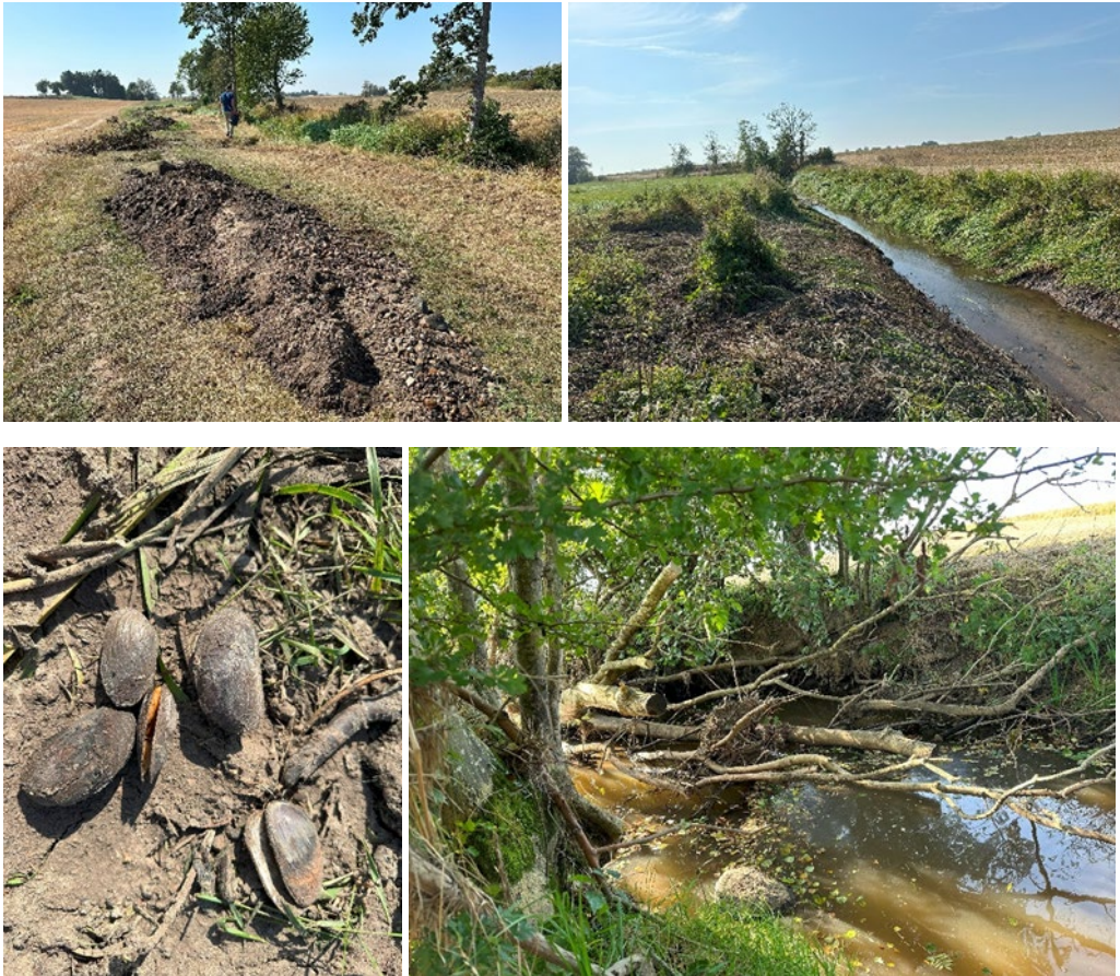
Figur 16. I Tommarpsån pågick en omfattande rensning vid provtagningstillfället. En sträcka på 1 km från väg 11 ända ner till kiselalgslokalens övre del hade rensats på både bottenmaterial och vattenvegetation samt en hel del skuggande träd hade tagits bort (överst t.v. och t.h.). I rensmassorna hittades levande och nydöda tjockskaliga målarmusslor ( Unio crassus , nederst t.v.), signalkräftor mm. Rensningen tillsammans med ett fallet träd nedströms lokalen (nederst t.h.) kan ha en påverkan på kiselalgssamhället p.g.a. grumling, sedimentation, uppdämning, försämrade skuggning etc.
